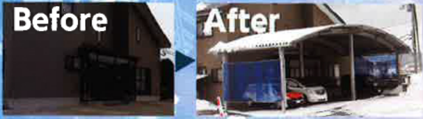
雪捨て場になっていたスペースに設置し、敷地の有効活用ができます
